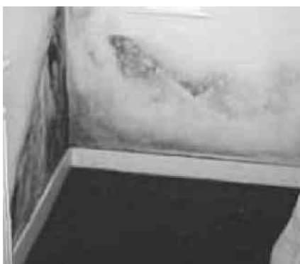
Ściany pokryte czarną pleśnią
